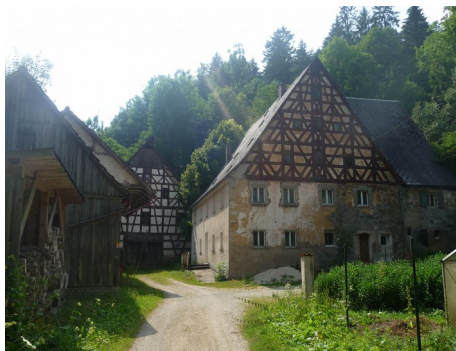
Griesmühle kurzer Abstecher ab Enzendorf
